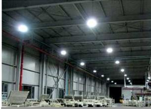
Hallentiefstrahler mit LEDs
